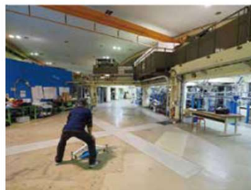
開発研究多機能ビームライン建設予定地の測量の様子(2023年8月)。旧BL-11A, B, Dの撤去が完了し、装置の一部は建設中のBL-12Aに移設される。
